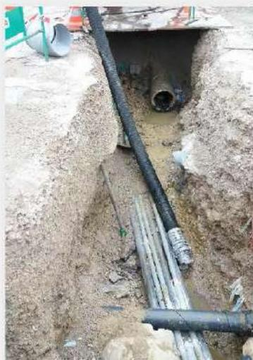
**Septembre-octobre** : Poursuite des travaux de pose de la fibre optique avec les aléas de gaines endommagées...
